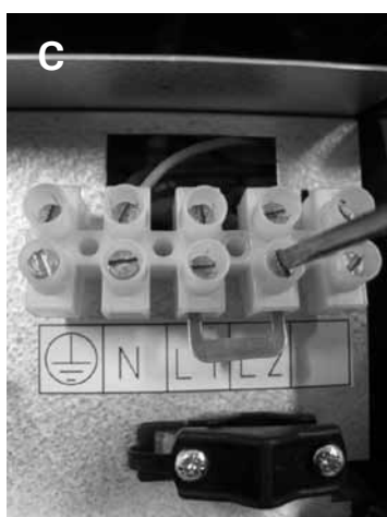
Рисунок 10 С и D. 1-фазное соединение каменки
